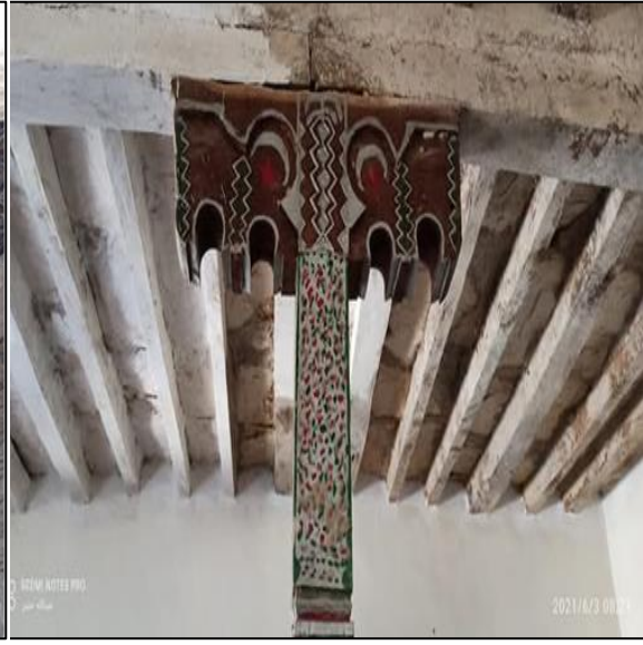
شكل (23) الدعامة الوسطية (السهم) والتاج (الكباش)
