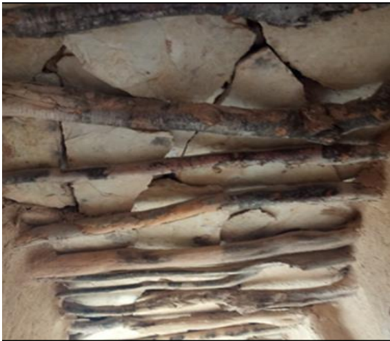
شكل (25) استخدام صفائح كبيرة من القرف أو الصليل في السقوف. [الباحث]
