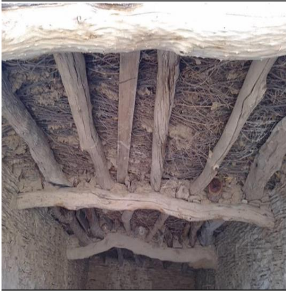
شكل (24) سقف من عيدان السدر وأغصان المضاض
