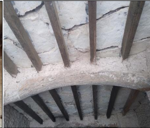
شكل (25) استخدام صفائح كبيرة من القرف أو الصليل في السقوف. [الباحث]
