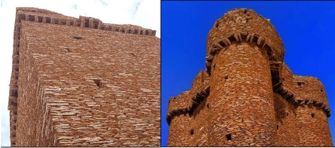
شكل (26) بروز السقف في القلاع (المصنعة). [الباحث] شكل (27) بروز السقف في الحصون [الباحث]
