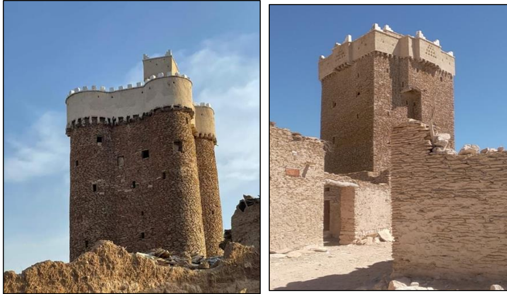
شكل (29) تلبس بالطين الأبيض وطلاء الجزء العلوي بالنورة لبعض المباني الدفاعية. [الباحث]
