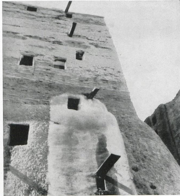
Hausfassade mit hölzernen Abflurrinnen für die Abwässer
