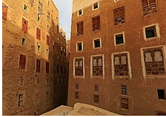
2 توضيح الصورة فتحات النوافذ للتهوية والإضاءة الطبيعية وفتحات والعُكر أسفل نوافذ الطابق الأول (23)
