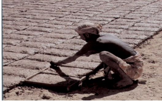
شكل رقم (1-1-4) يوضح شكل وحجم الطوب الطيني وعملية تصنيعه اليدوية في وادي حضرموت
