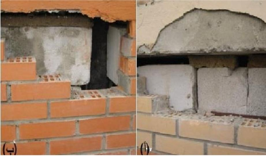
يلاحظ أي شخص غير مُتخصِّص بهيكل المبنى وخصائص حوائطه، العيب الموضَّح في (الشكل 9أ). وهو تغطية طرف بلاطة الأرضية بطبقة من الصوف المعدني، والتي يرتكز عليها جدار الطوب للطابق العلوي، فيظهر التصوير الحراري في (الشكل 10) بأن الوحدة معزولة جيداً، لكنه في الحقيقة عيب جسيم قد يؤدي إلى تدمير هيكل الجدار كاملاً. وكذلك الطرف غير المعزول للقاطع الجداري الداخلي في (الشكل 9ب)، لا تتعكس صورته على الإطلاق في جهاز المسح الحراري في (الشكل 10)، حيث إن الفجوة الهوائية الموجودة بين طرف القاطع وكسوة الواجهة تمنع ذلك.
