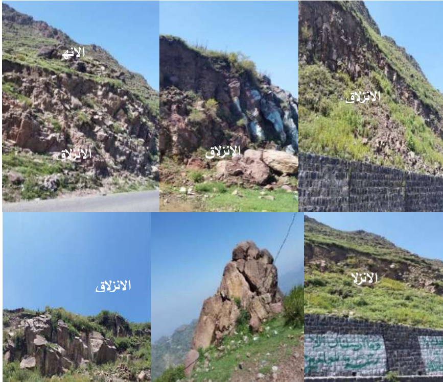
لوحة (15): نماذج لحالات الانهيار الانقلابي والانزلاق المستوي والانزلاق الإسفيني نتيجة لكثرة الشقوق والفواصل (الانقطاعات) في صخور المنحدرات المطللة على الجانب الأيمن لطريق نقيل سُمارة في المنطقة الرابعة. المصدر: الدراسة الميدانية بتاريخ 12-8-2021م.
