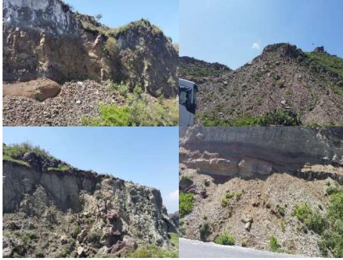
لوحة (12): نماذج لحالات الانزلاق المستوي للصخور والحطام الصخري والترتبة في المنحدرات المطلة على الجانب الأيمن لطريق نقيب شمارة في المنطقة الرابعة. المصدر: الدراسة الميدانية بتاريخ 2021-8-12م.
